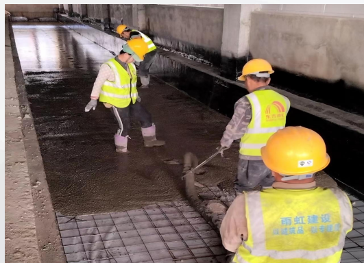
浇筑混凝土
