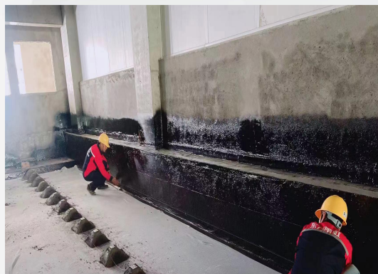
铺设土工布及打点放线
