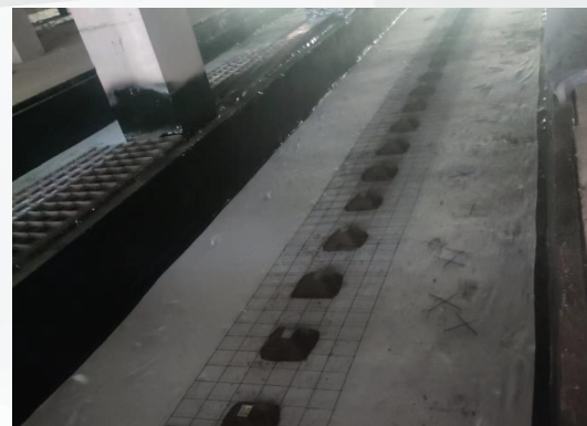
铺设钢筋网片
