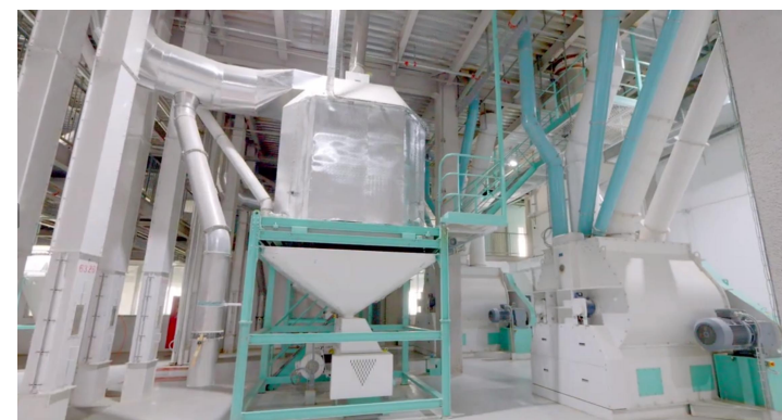
斯派莎克蒸汽管路
