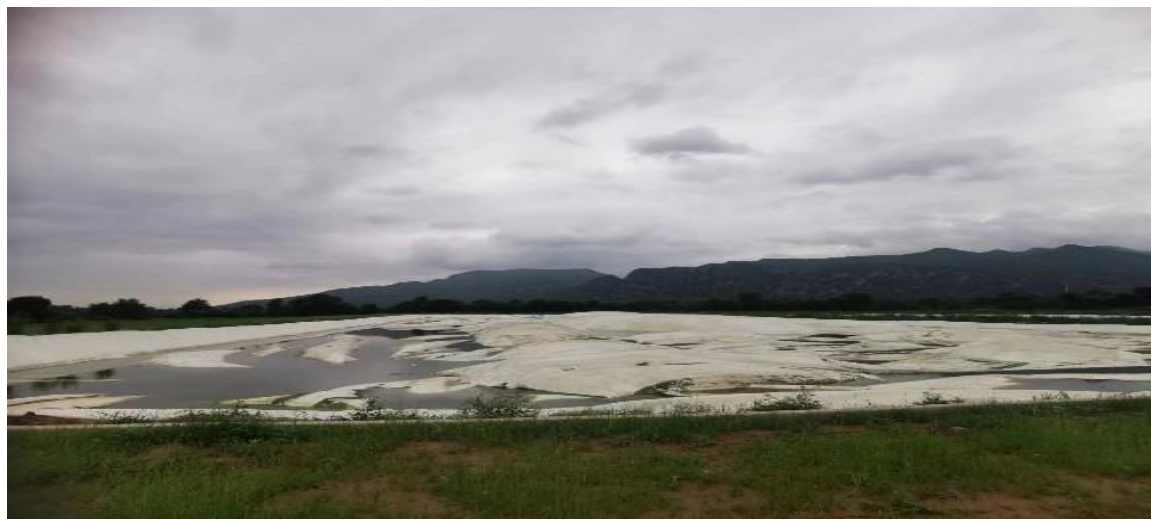
延庆丰森源覆膜储存池
