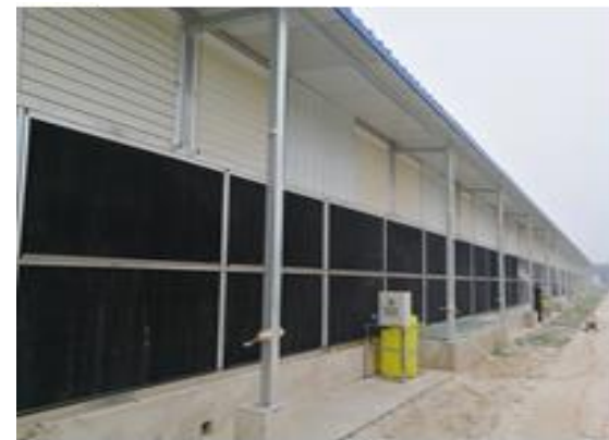
滤墙除臭【房山】
